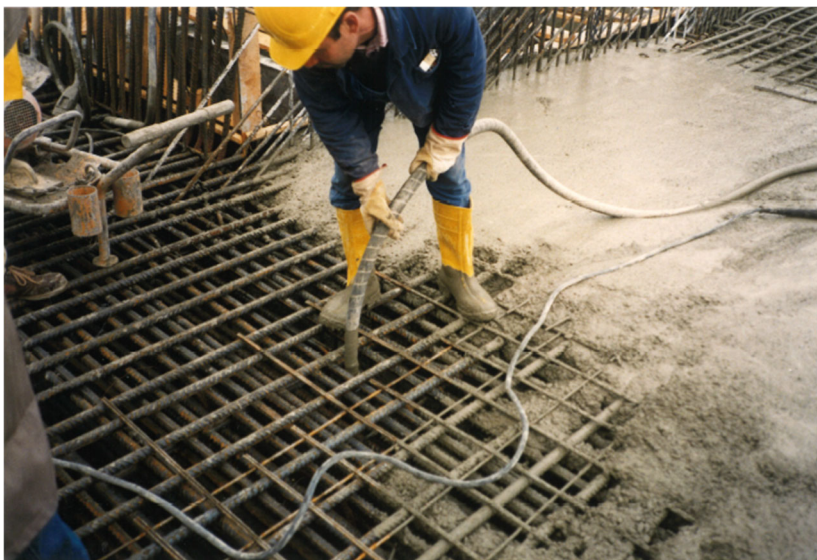
Abb. 7 Bewehrungs- und Betonierarbeiten Terminal 1 Geschossdecken (1989)
