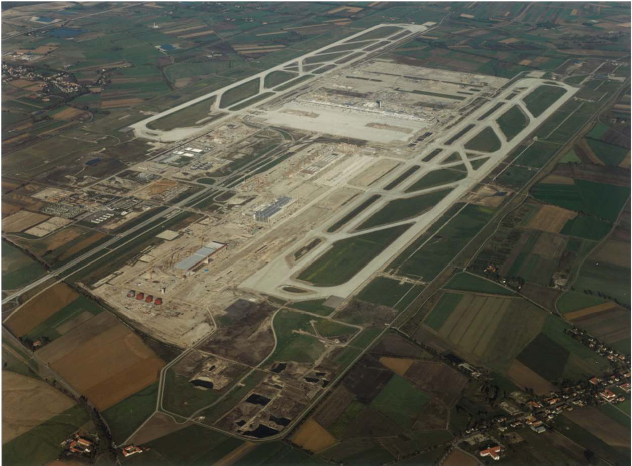
Abb. 5 Flughafen München in Bauphase im Jahr 1990
